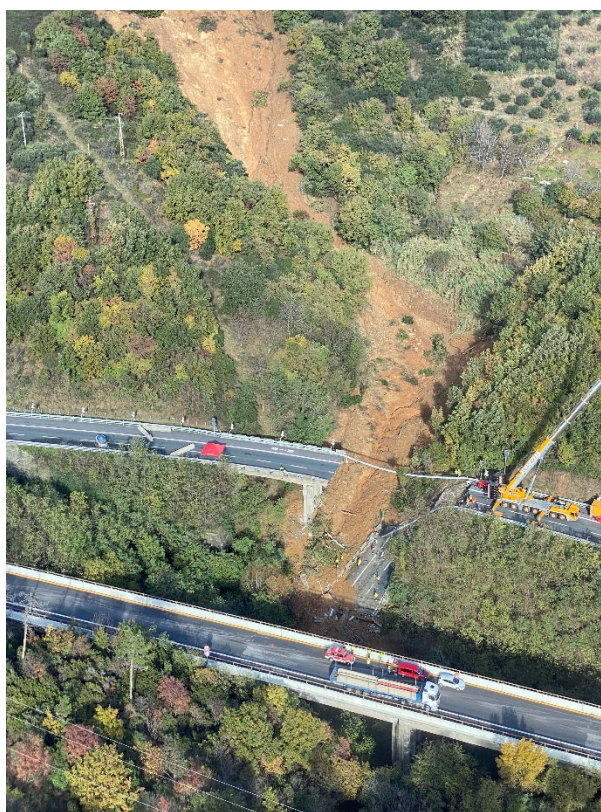
Figura 1 – Foto della frana, dei due viadotti e della carreggiata ruotata di 90° (foto scattata da elicottero il 25 novembre 2019).
