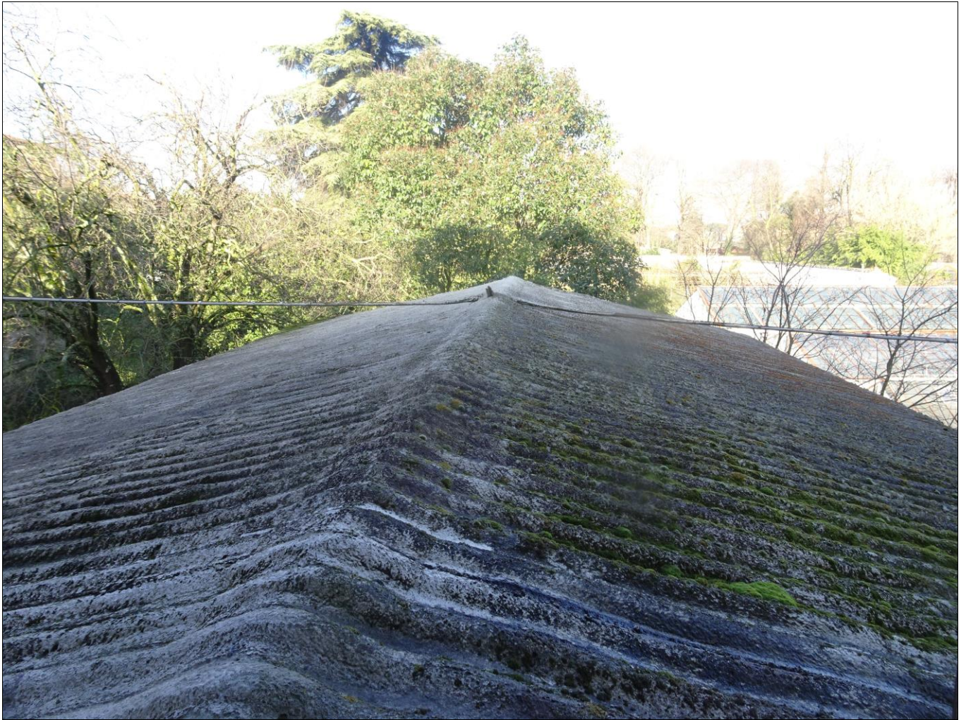
Attuale copertura in eternit
