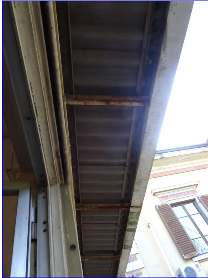
Aggetto della copertura vista dal basso
