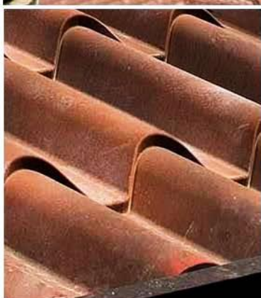
Dettaglio della copertura
